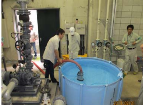
仮設電源（発動発電機）で水中ポンプを稼動し、地下仮設給水タンクから地上の給水タンクへ揚水訓練
