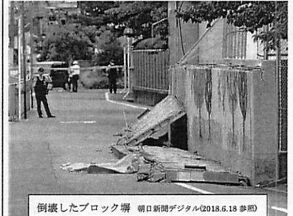
倒壊したブロック塀 朝日新聞デジタル(2018.6.18参照)
